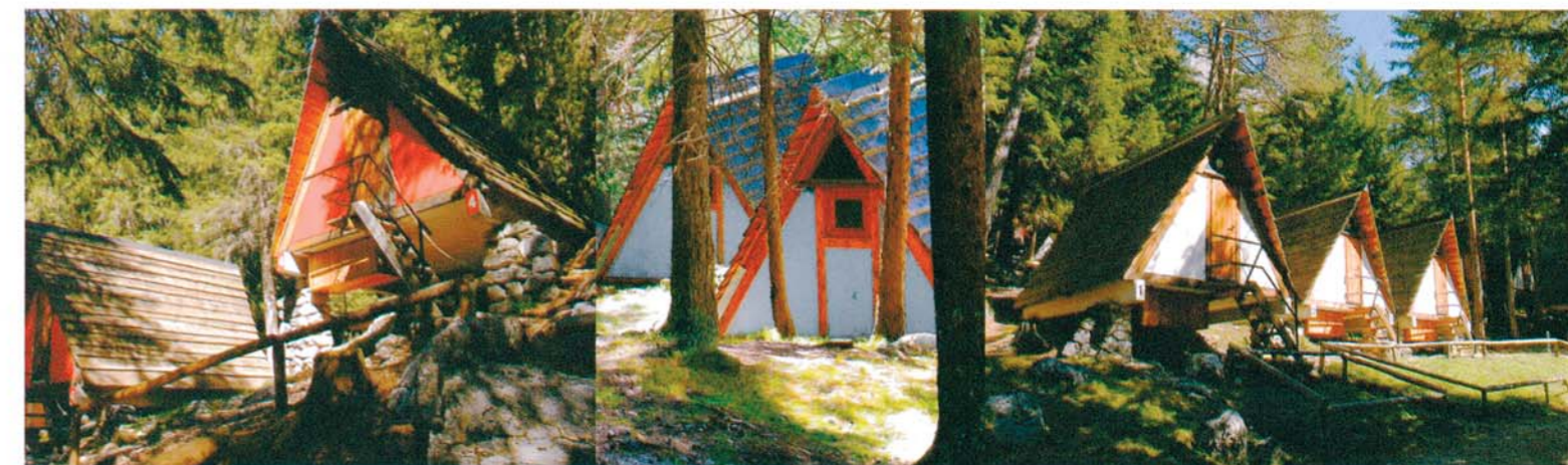
In questa pagina, dall'alto, vista del fronte dell'ex-colonia estiva, l'interno della camerata e il corridoio distributivo. Il campeggio oggi in funzione, gestito dalla parrocchia vicentina di Sant'Andrea e il Collegio Graziani di Bassano.
