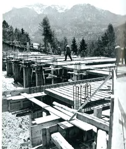
Vista del cantiere di uno dei dormitori (©Edoardo Gellner-Archivio StudioGellner)
