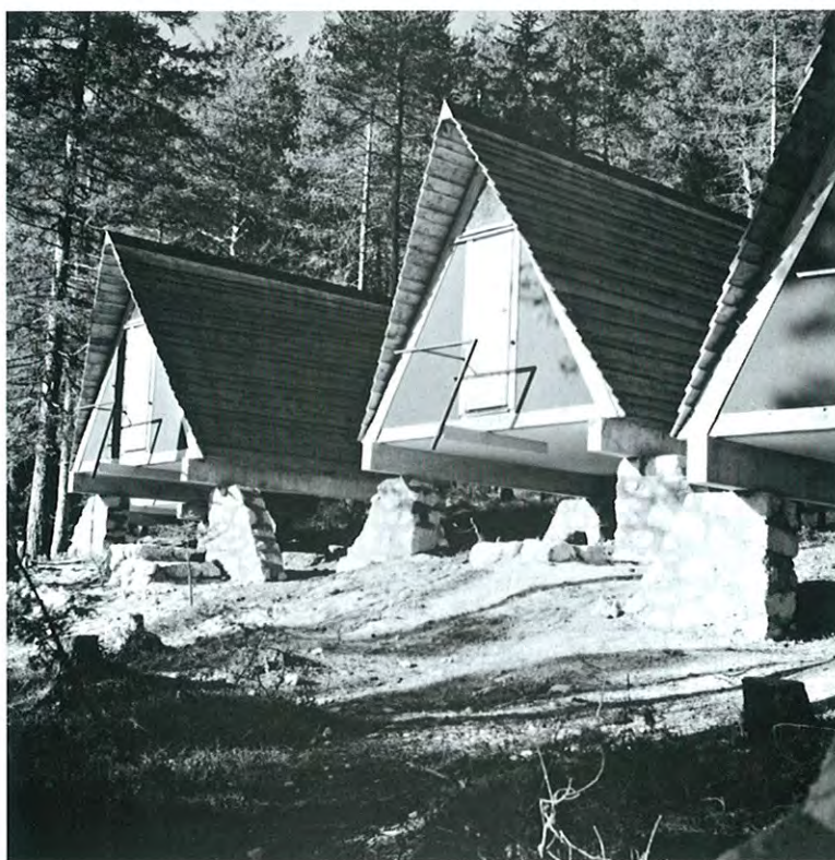
Le capanne in costruzione (©Edoardo Gellner-Archivio StudioGellner) In basso: prospetto nord di una delle capanne (ASE)
