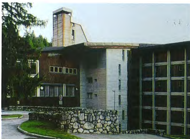
Albergo Boite. Vista fronte nord (da Edoardo Gellner, Corte di Cadore ) A destra, Albergo Corte. Veduta del fronte nord (©Aldo Ballo - Archivio StudioGellner)
